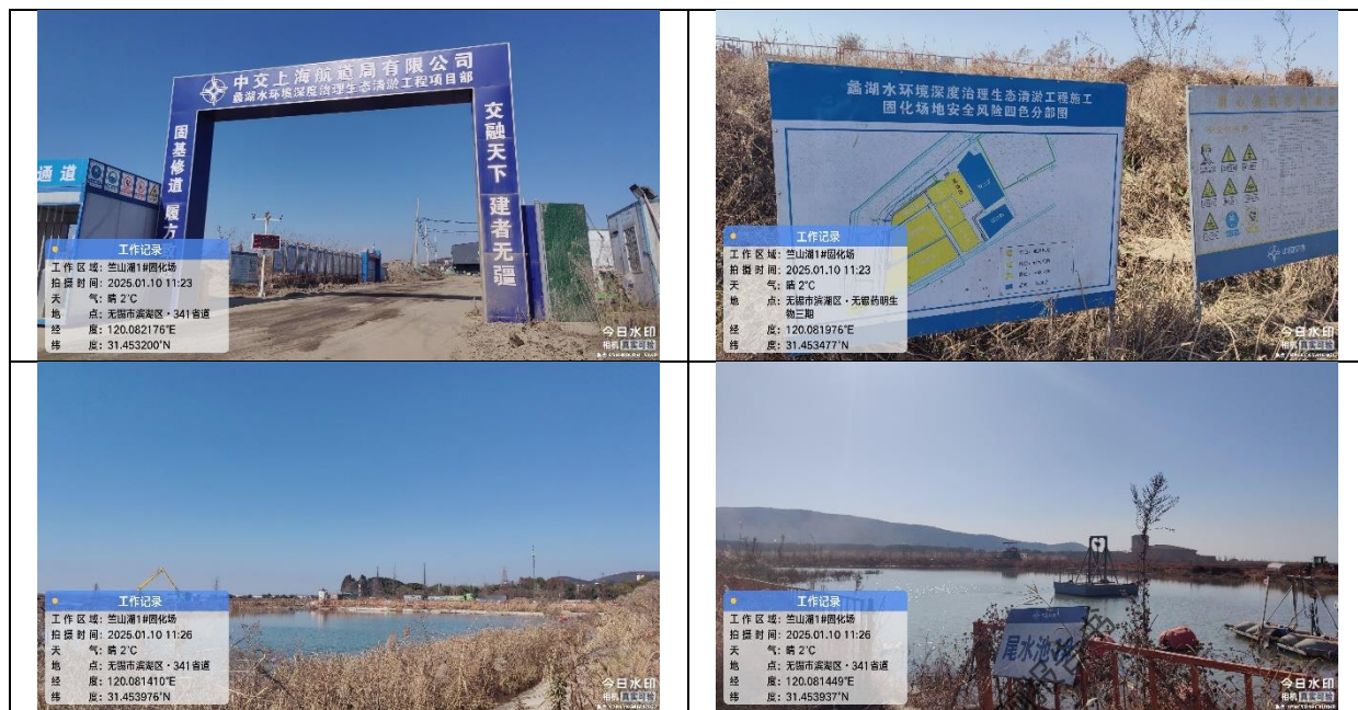
图 3.3-5 蠡湖水环境深度治理生态清淤工程固化场情况
